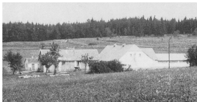
▲ Obr. 14 : Pohled na historickou usedlost v polích No. 80 existující od roku 1637, zbořenou po požáru v r. 1963 (foto 40. léta 20. století, ze sbírek S. Kočího z Hůrek).
