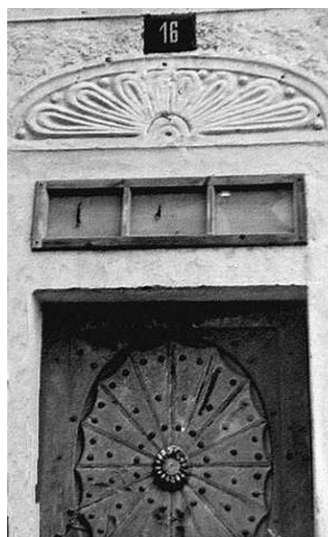
Obr. 19 : Detailní pohled na klasicistní dveře bočního vstupu domu No. 40 /čp. 16 z roku 1976 před jejich likvidací při rekonstrukci (foto ze sbírky rod.Vertelmannů z Hůrek)
